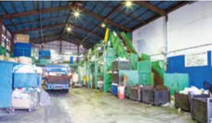
板橋工場 内観
